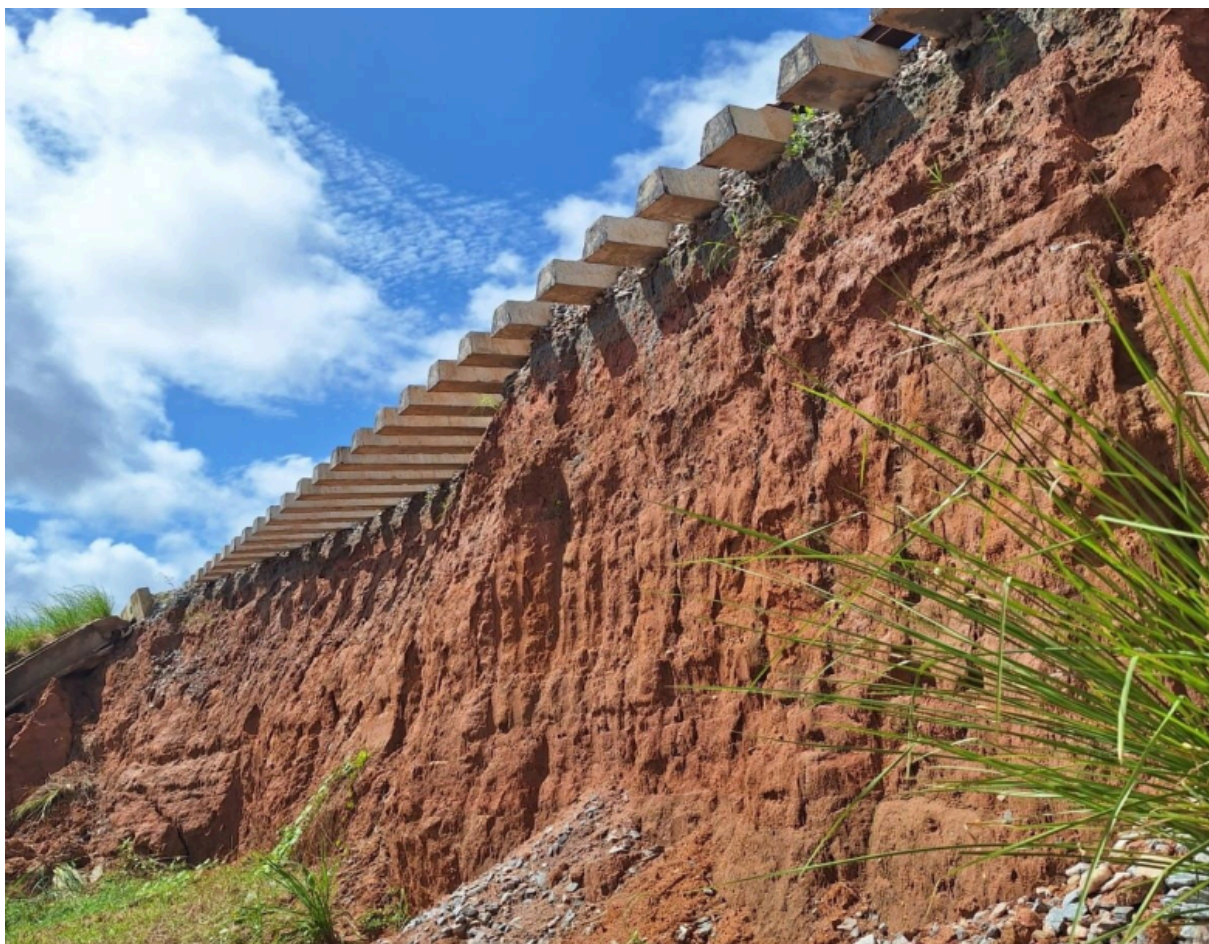
Figura 3: Extensão de via afetada pelo rompimento da adutora.
