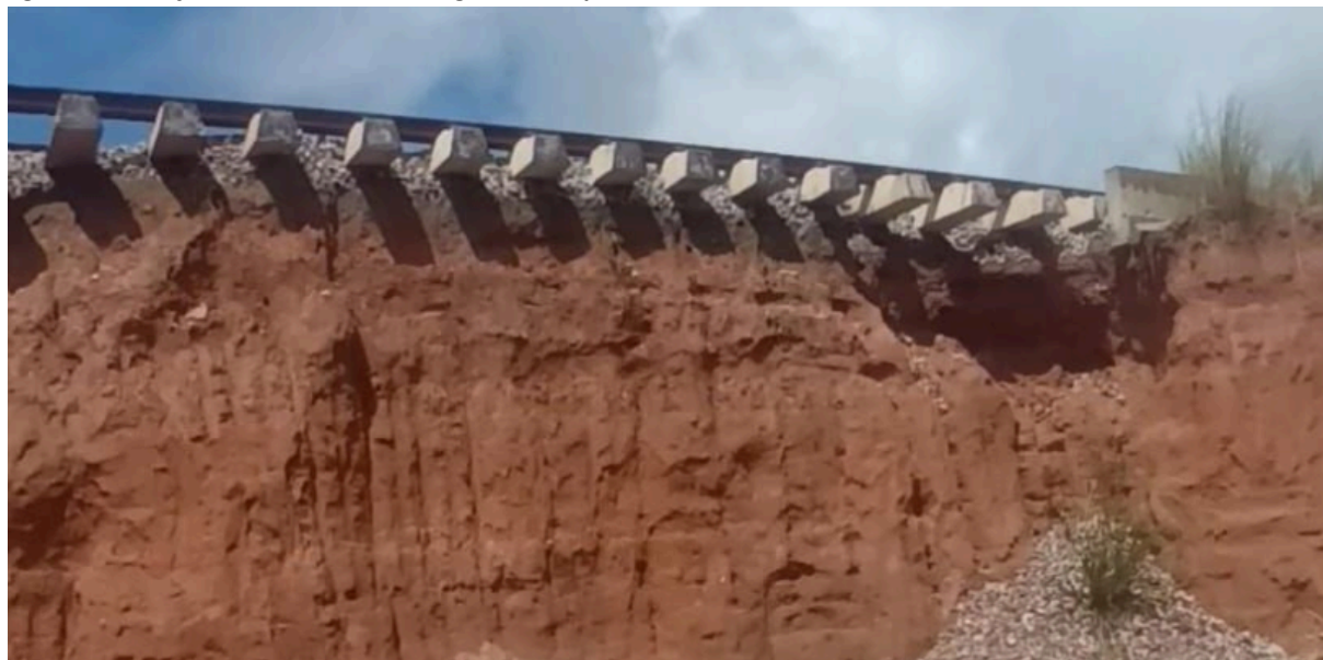
Figura 2: Escavação do talude acima da região de rompimento da adutora - continuação.
